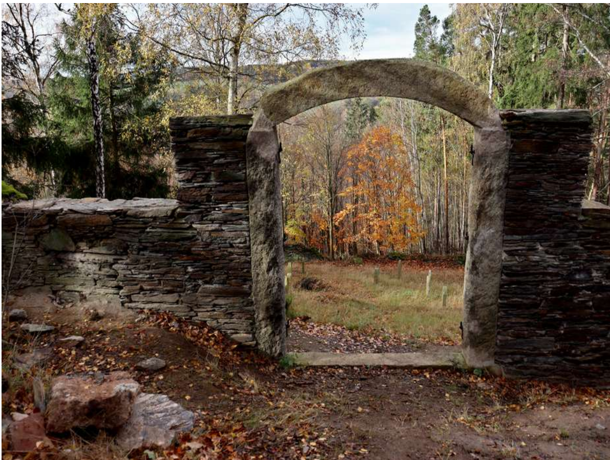
Svojšín - renovovaná brána židovského hřbitova / Schweissing - restored cemetery gate
